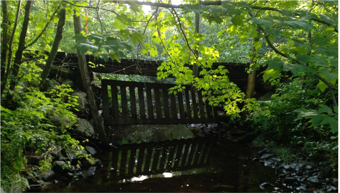
Photo 7 : Pont avec clôture pouvant causer des embâcles dans le bassin de la rivière Noire, le 11 août 2020.
